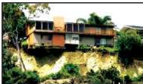
Рис. 26. Разрушения вследствие стихийного бедствия.
