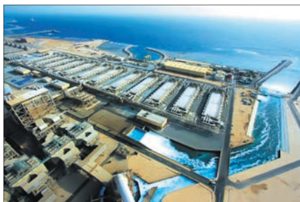
Рис. 70. Завод по опреснению морской воды
