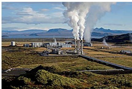
Рис. 4. Геотермальная электростанция в Исландии
