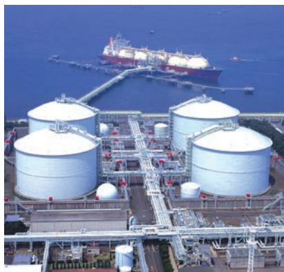
Рис. 16. Резервуары для хранения сжиженного природного газа
